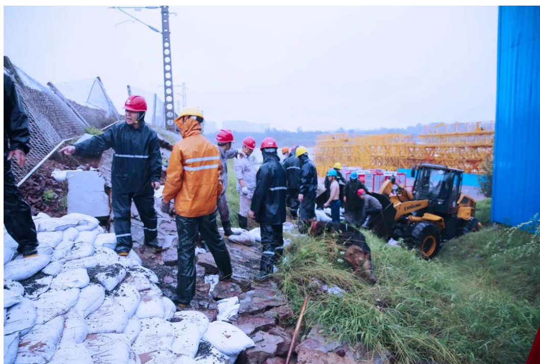
荥阳热电公司抢修铁路专用线
