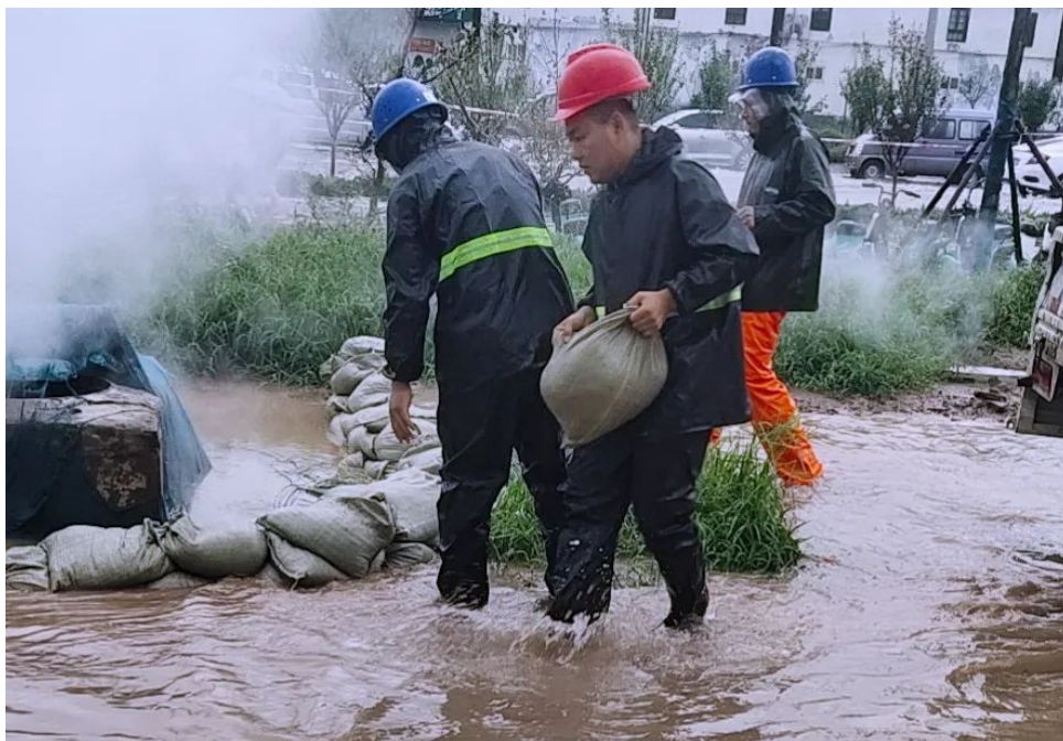
济源发电公司员工对观察井周围积水进行沙袋围堵
