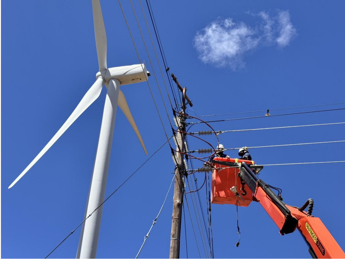
图2公司在杆塔合适位置为鸟类搭建特制栖息架
