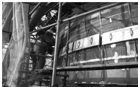
图3 电加热处理现场
