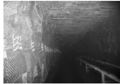
图 6 采用卸压爆破后巷道支护情况
