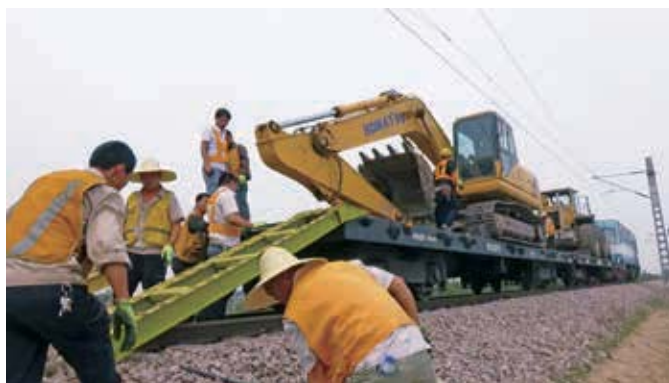
朔黄铁路原平分公司在原塘联络线举行高路基地段大型机械防洪抢险演练
