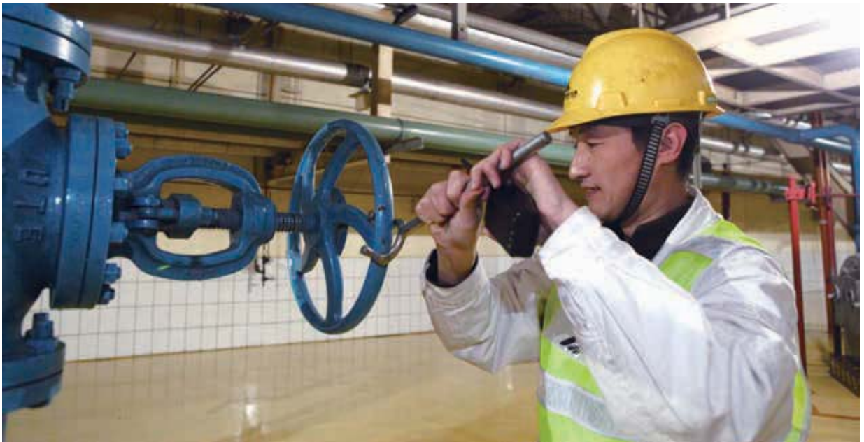
三河电厂运行人员正在进行设备操作
