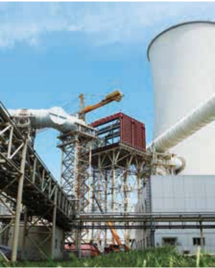
国华三河电厂4号机组湿式电除尘改造现场
